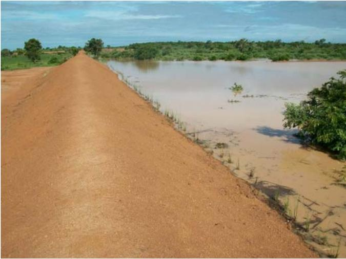
Les travaux du bulli avec déversoir de Tibkoulga ont démarré en Janvier avec le creusement de la tranchée d'étanchéité, suivi de la confection de la digue (505 mètres), réalisée avec la terre de creusement du déversoir (243 m<sup>3</sup>), du canal (1.247 m<sup>3</sup>), et du bulli (2.500 m<sup>3</sup>). Ce sont 164 équipes de contractuels qui se sont retrouvées sur ce chantier, soit environ
